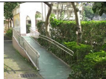
符合人性化的殘障坡道
