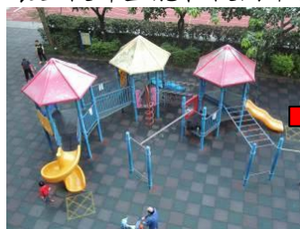
遊戲器材整修(施工前)
