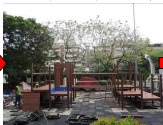
遊戲器材整修(施工中)
